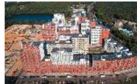
ЖК «Новокрасово», МО «Тройка РЭД»
